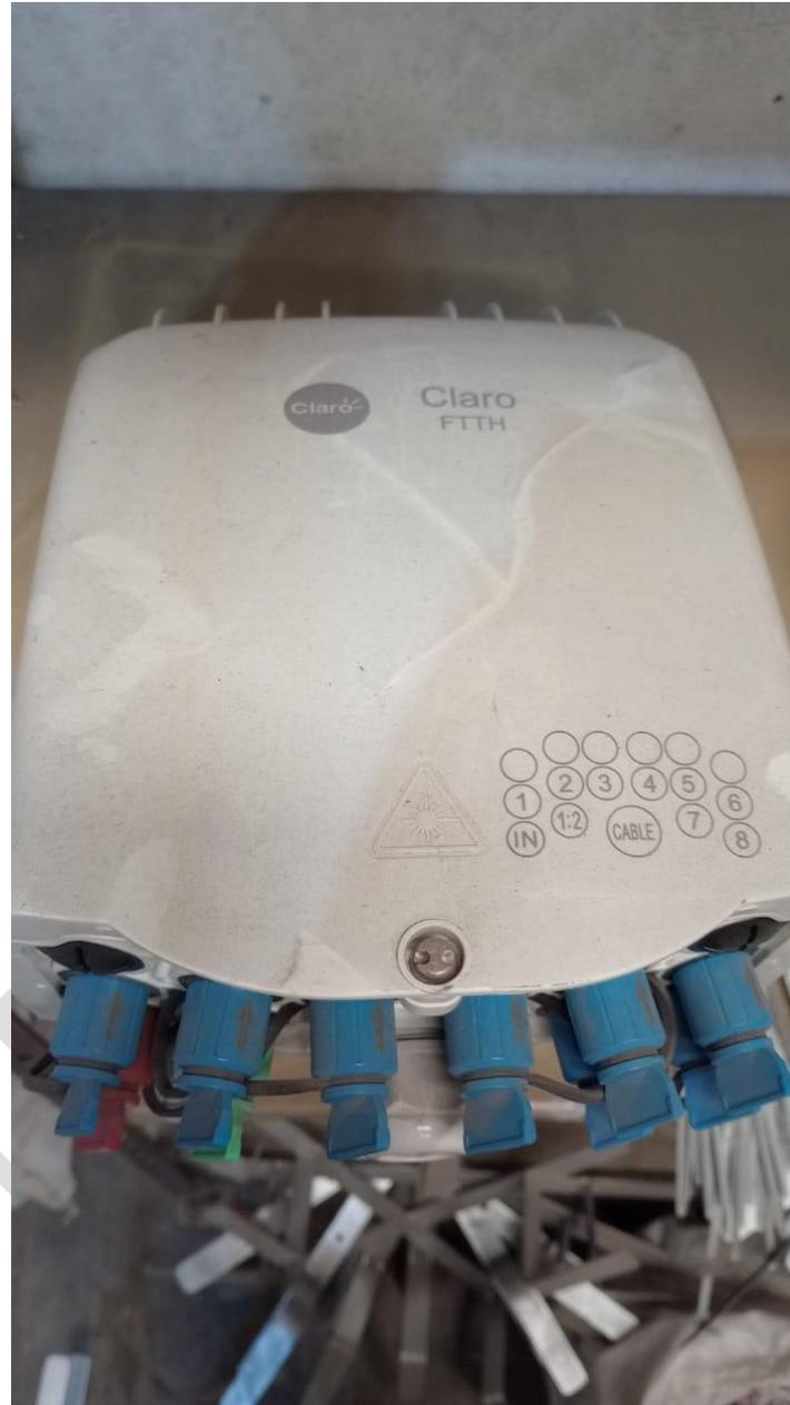
Las **CVAP** tienen la capacidad de alimentar 8 **CVA**, teniendo en su interior fibras empalmadas y preparadas para conectar cables E&F, se caracterizan por tener pasivas de color azules, para distinguirse de las demás.
