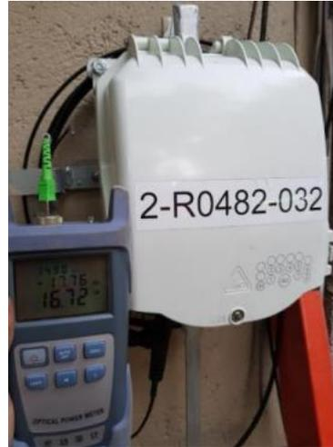
5. Una vez medida la potencia en el splitter, el técnico baja a buscar el cable de fibra para el tendido hacia el domicilio y sube con el cinturón porta herramientas con (alicate de corte, clamp o retención para la fibra, gancho galvanizado, cadenas (si es necesario) precinto rojo para nombrar e identificar al cliente, precinto negro).
